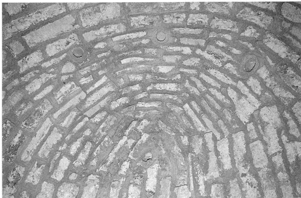
Fig. 7. San Fructuoso de Barós. Anforas de resonancia o acústicas en la bóveda absidial.
