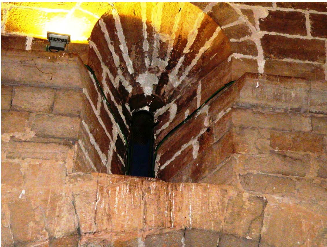
Ventana interior Pared Sur s1 Foto 1860809
