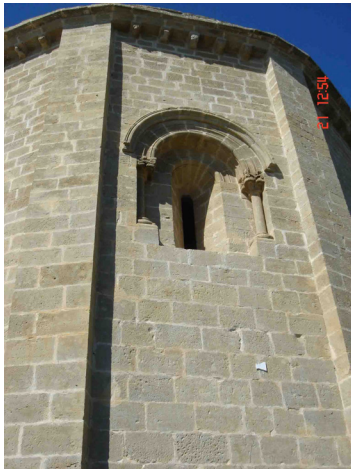
Paramento exterior del ábside, con un testigo de yeso roto por la abertura activa de la grieta vertical
