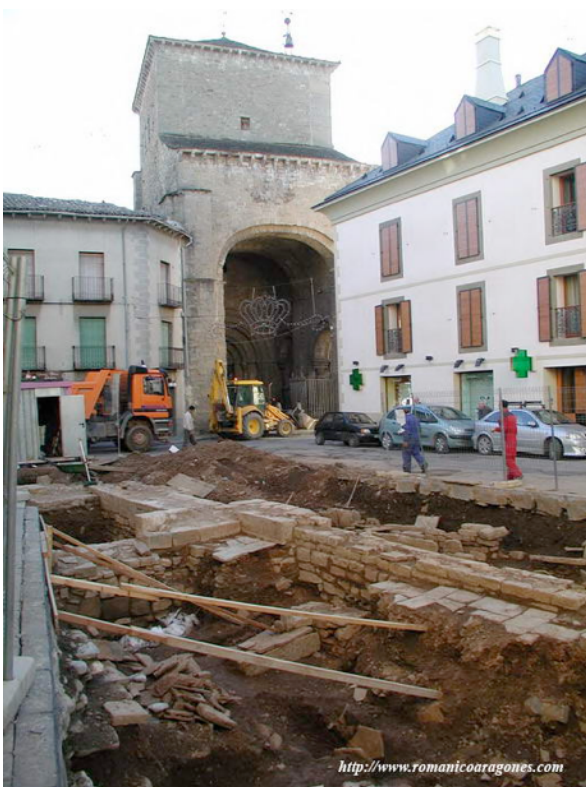
Fig. 6. Jaca: Excavación de S. Pedro El Viejo
