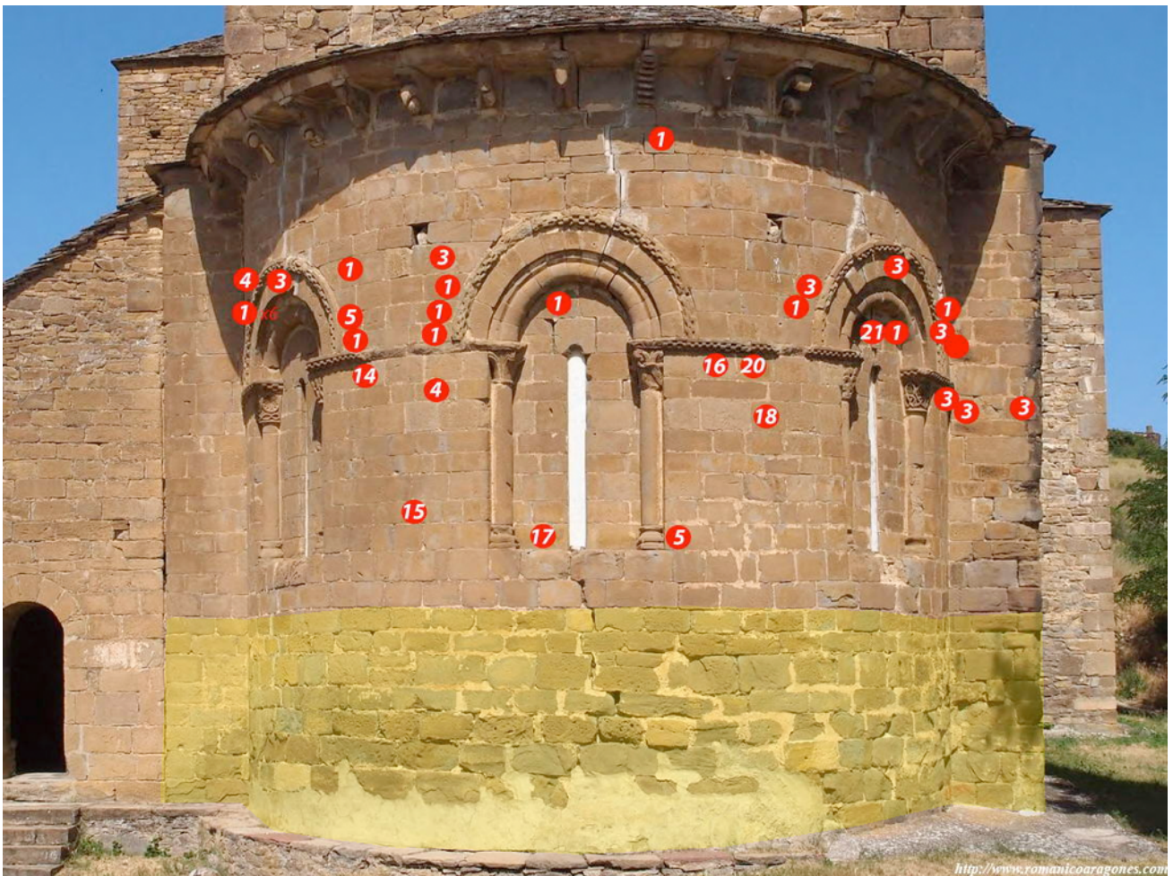
Fig. 4. Cabecera: cambio del estilo de sillares (amarillo) y ubicación de marcas de cantería (círculos rojos).
